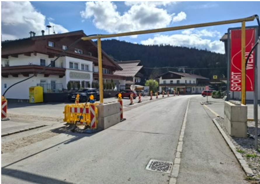
Überbrückung des Provisoriums der Wasserversorgung. Foto: Gemeinde Leutasch
