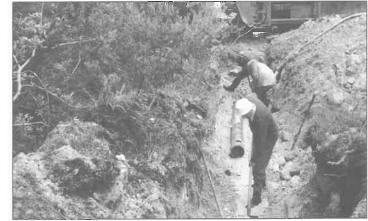
Erneuerung der Bachquerung beim Bau der Schweiglbrücke
