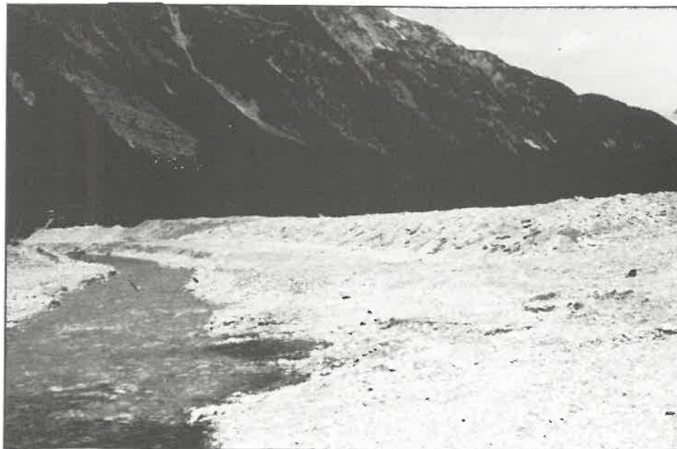
Acheverbauung in Reindlau
