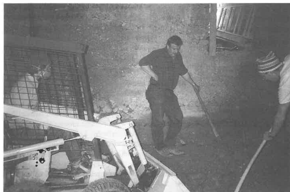
Beginn der Sanierungsarbeiten im Keller des Vereinshauses im Mai 1994.
