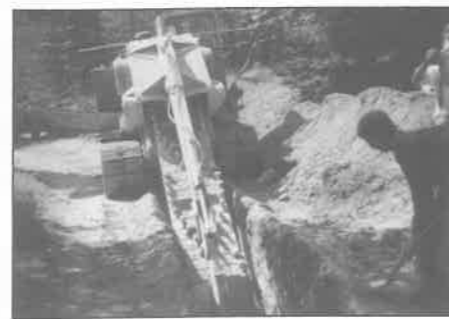
Zu- und Ableitungen in einer Gesamtlänge von über 2,5 km mußten verlegt werden.
