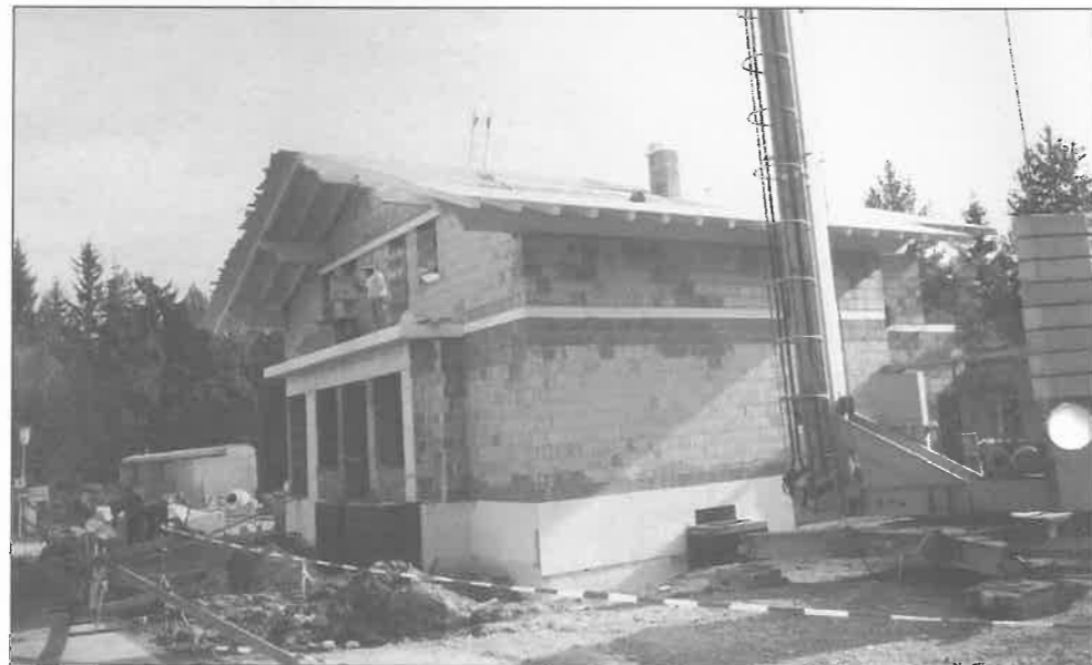
Das gute Herbstwetter begünstigte den raschen Baufortschritt des Schlachthauses
