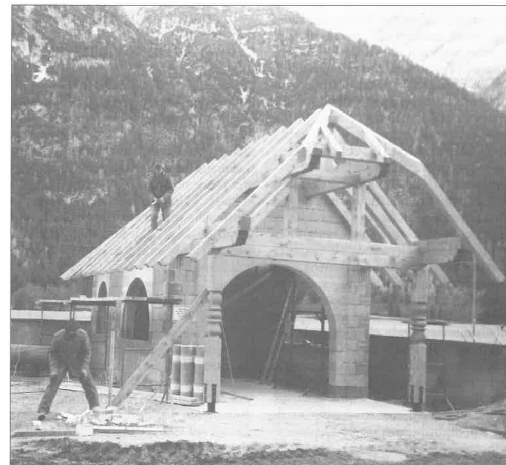
Von den Bauhofarbeitern in Eigenregie errichtet: Leichenkapelle Unterleutasch
