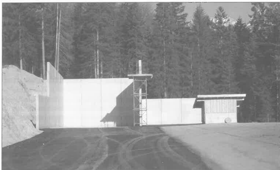
Inzwischen ist auch das Dach fertig
