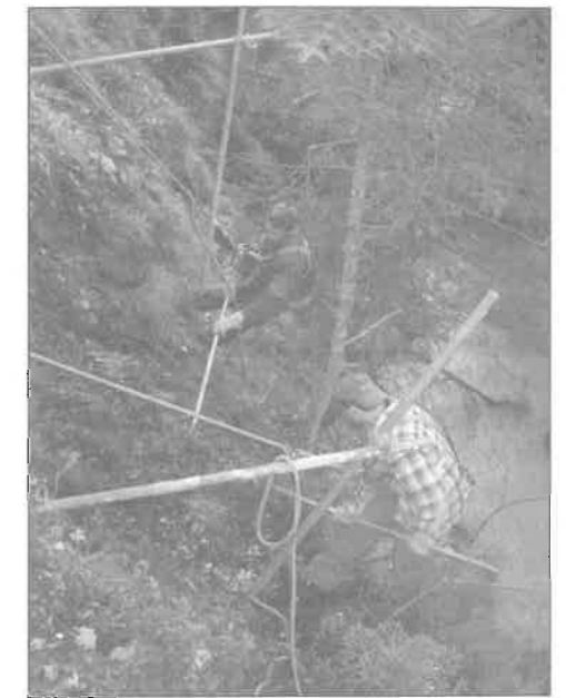
Arbeiten hoch über dem Abgrund
