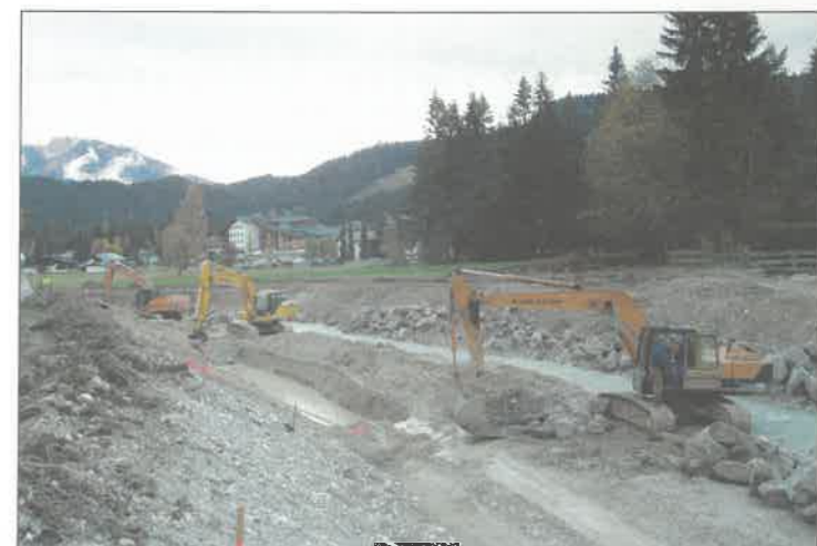
Nach der Aufweitung des Flussbettes müssen nun die Ufer verbaut werden - eine Arbeit, die selbst im Winter fortgesetzt werden kann
