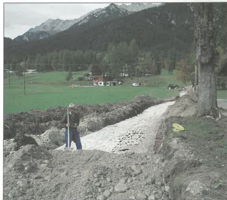
Auf diesen Bildern wird klar, wie umfangreich und aufwändig die Straßenbauarbeiten auf diesem letzten Teilstück gewesen sind
