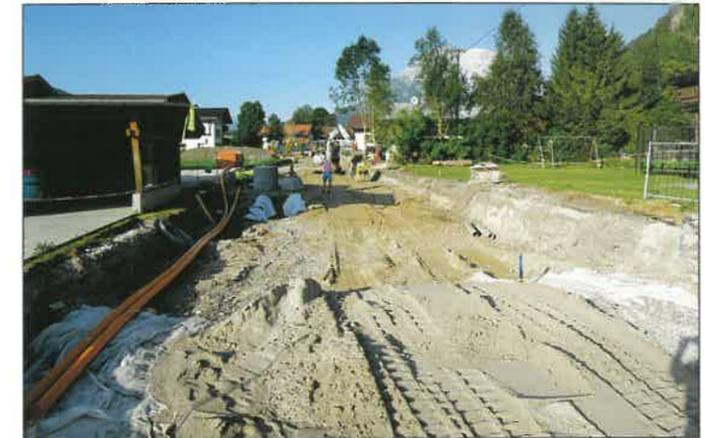
Beim Straßenbaulos Gasse-Ahrn konnten gleichzeitig die Rohre für die Erdgasversorgung verlegt werden
